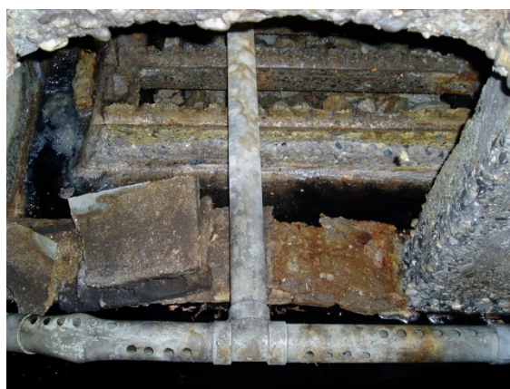
腐食により破損した散水ろ床樋部(2例とも)
