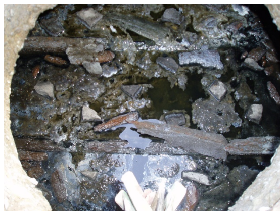
槽内の腐食により破損した平面酸化床
