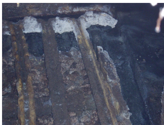
腐食により破損した散水ろ床樋部(2例とも)
